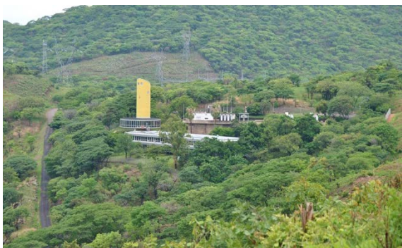
Picture 6 The Kafue Gorge Hydro Power Plant
